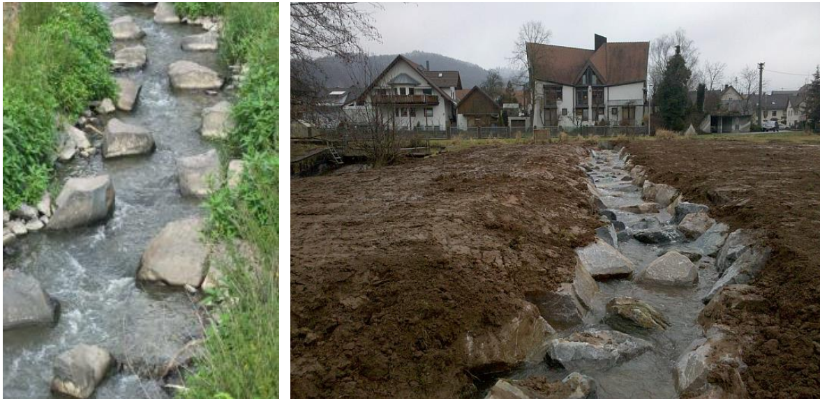
Abb. 4: links: Umgehungsgerinne in Form eines Raugerinnes mit Störsteinen am Elbbach bei Hadamar (Hessen) [1]; rechts: Fischtrappe in Reichenbach (Stadt Lahr, Schwarzwald) [7]
