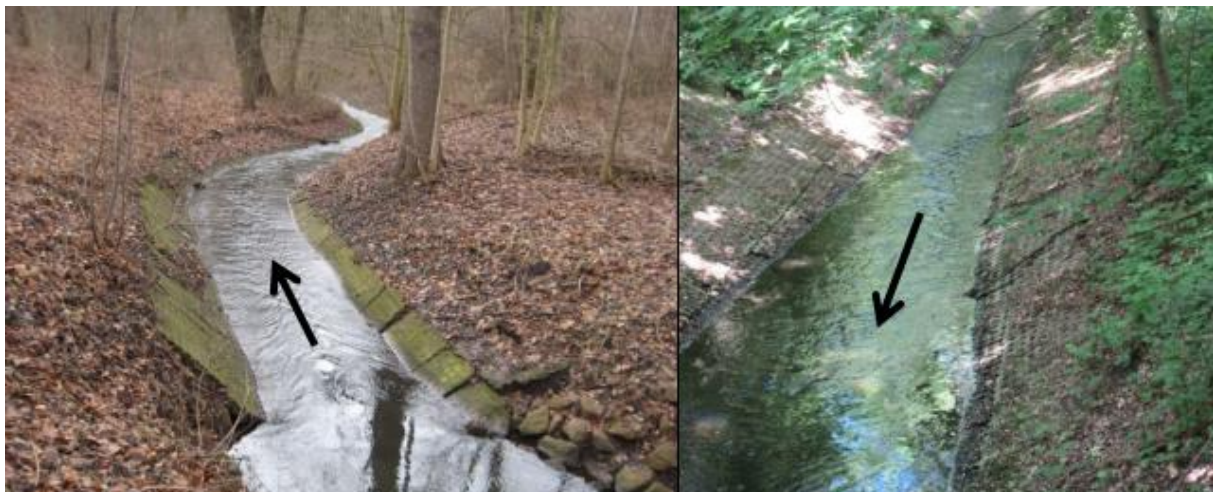
Abb. 3: Schussstrecke Dieskauer Park an der Reide, Station Fl.-km 2+550
